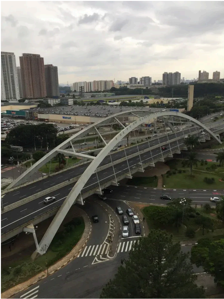
Ponte metálica de Osasco, vista aérea.
