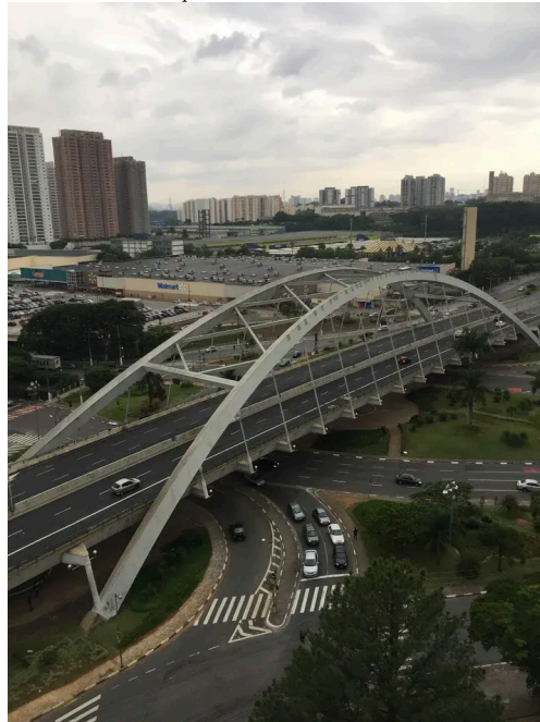
Ponte metálica de Osasco, vista aérea.
